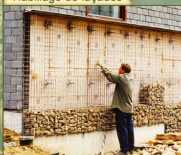
Habillage de façades
