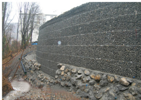
Mise en oeuvre du remblai par couches de 50 cm avec parement de gabion en 1 m.
