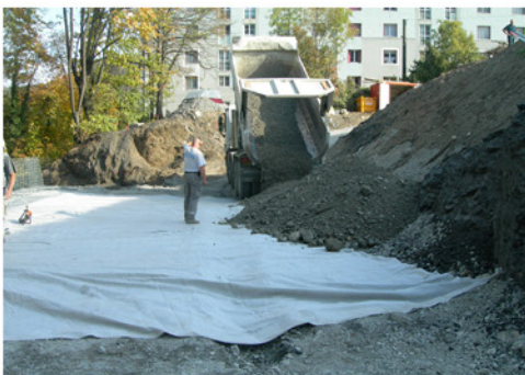
Tranchée de mise en tension du géosynthétique.
