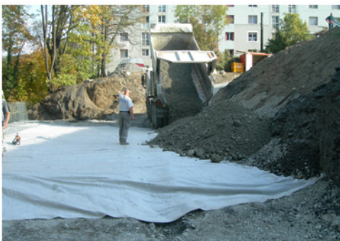
Tranchée de mise en tension du géosynthétique.
