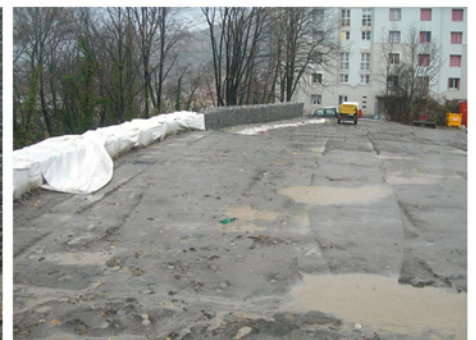
Mise en oeuvre du remblai par couches de 50 cm avec parement de gabion en 1 m.
