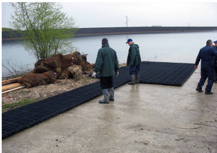
Mise en œuvre des modules flottants pour une surface totale de radeaux végétalisés de plus de 300 m 2
