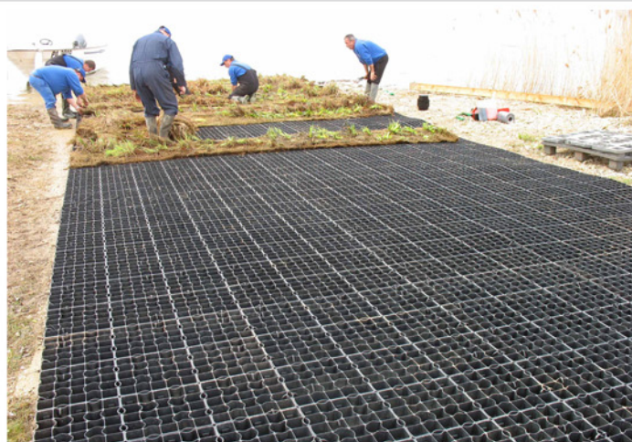
Mise en œuvre des modules flottants pour une surface totale de radeaux végétalisés de plus de 300 m 2
