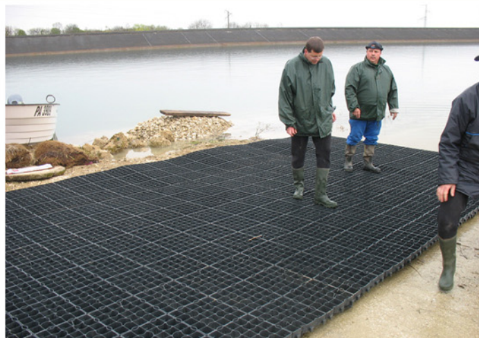
Mise en œuvre des modules flottants pour une surface totale de radeaux végétalisés de plus de 300 m 2
